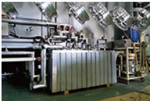
ガスボイラーとヒートポンプのハイブリッド運用でCO 2 排出量を削減
