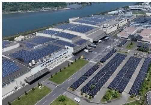
PV導入事例
